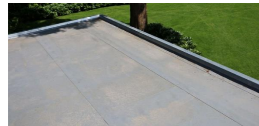
Figuur 24: pvc-dak bekleding
