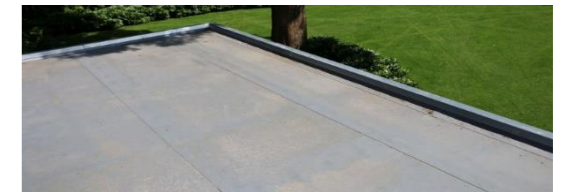
Figuur 19: pvc-dak bekleding
