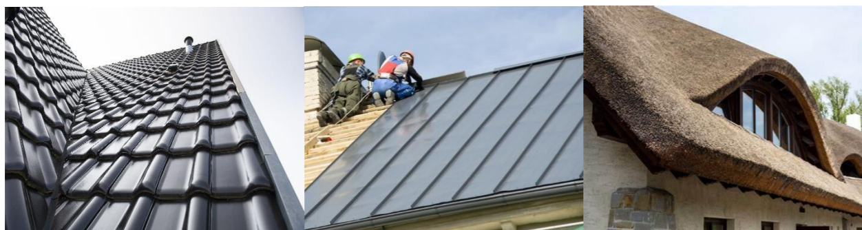
Figuur 18: van links naar rechts = keramische dakpannen, zinken dak, rieten dak
