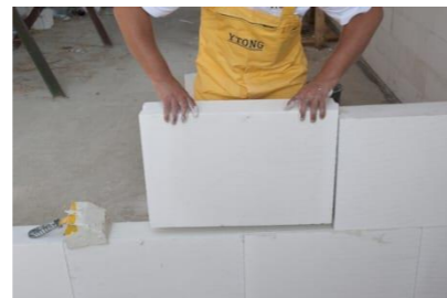
Figuur 12: gipsblok wand
