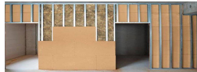
Figuur 13: Metal stud wand
