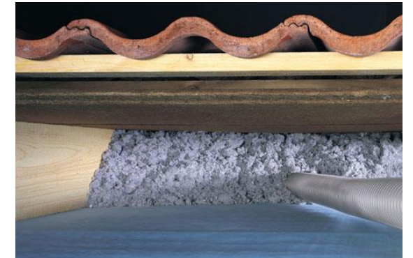
Figuur 5: inbrengen isolatiemateriaal cellulose
